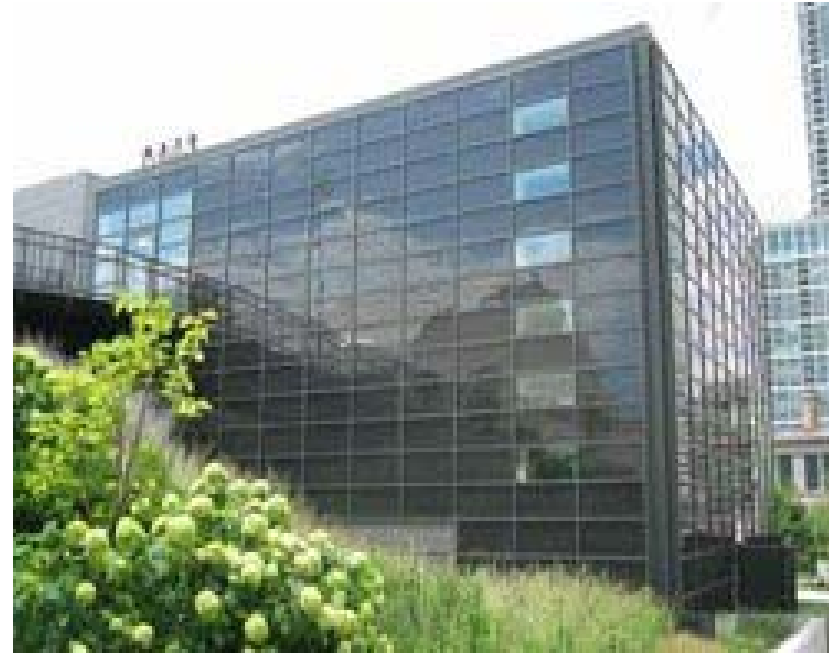
Sağır yüzeylerde güneş pili uygulaması
