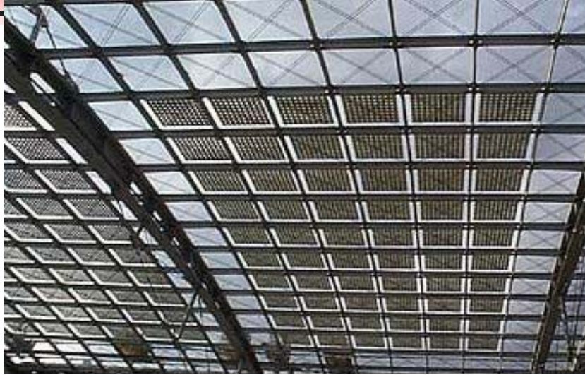
Güneş pilleri içeren bir çatı ışıklığı uygulaması
